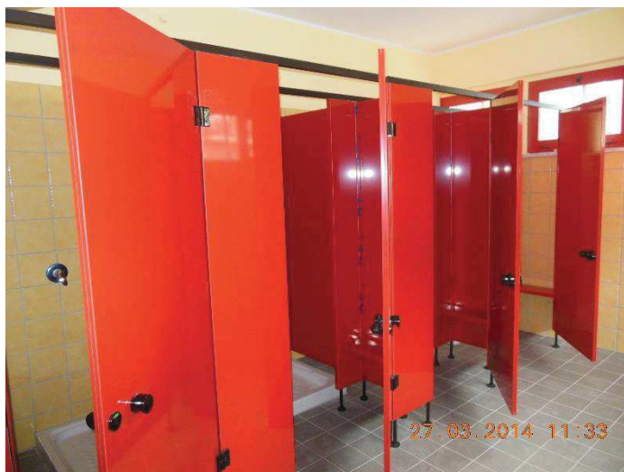
Rifacimento dei servizi igienici a servizio della palestra.
